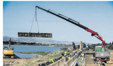
Obras del corredor mediterráneo, una vía clave para la competitividad futura de las empresas valencianas
